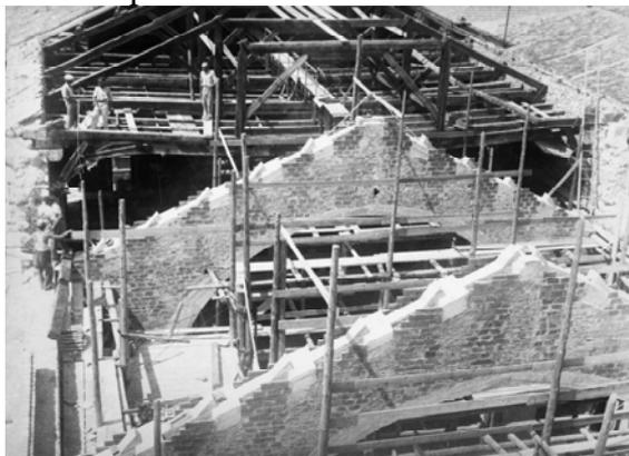
La costruzione dei nuovi arconi in cemento armato. Si notano le capriate alla palladiana del tetto originale
